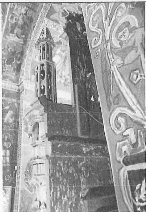
Verso-ul conostasului lateral - starea generală de conservare- se remarcă exfolieri masive ale stratului de lac
