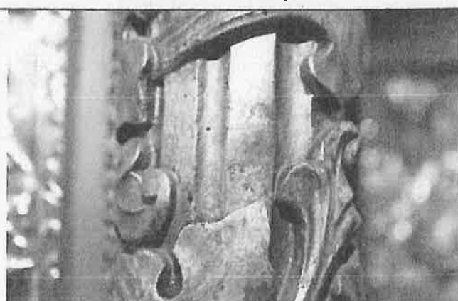
Pierderea stratului pictural la nivelul coloanei datorită uzurii funcționale
