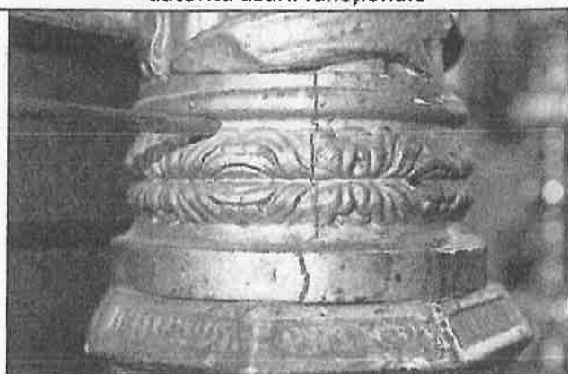
Detaliu crăpătură la nivelul coloanelor
