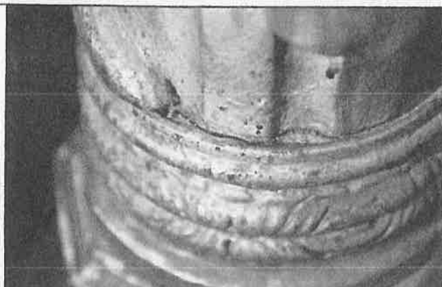
Iconostas lateral - localizarea atacului de insecte xilofage la nivelul coloanei
