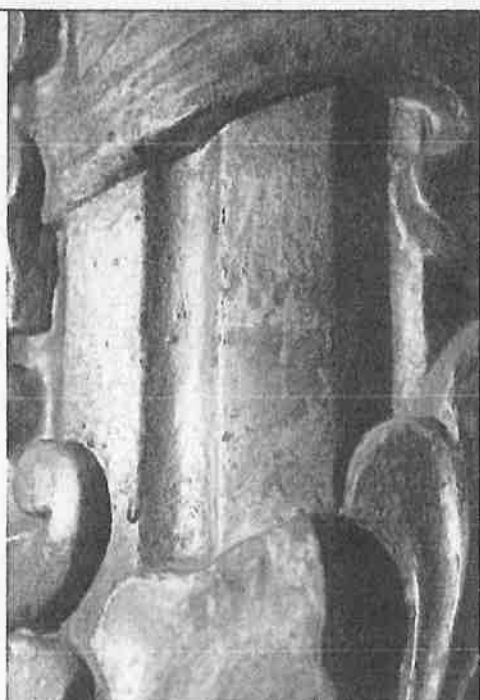
Pierdere stratului pictural la nivelul colonetei datorită uzurii funcționale
