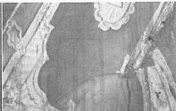
Trasee de scurgere al produșilor de coroziune proveniți de la ferecăturile de metal ⇅
