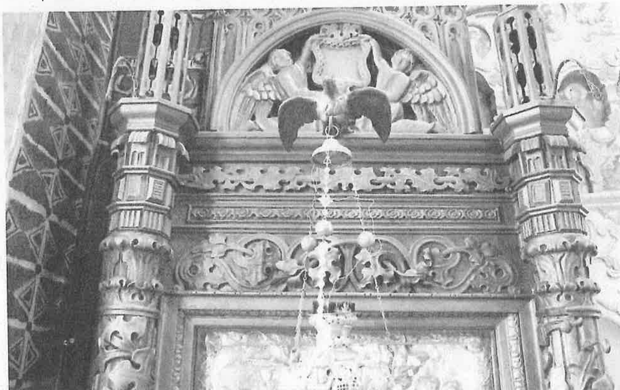
Elemente sculptate din lemn de tei, adăugate unui panou plat din lemn de brad ↑
