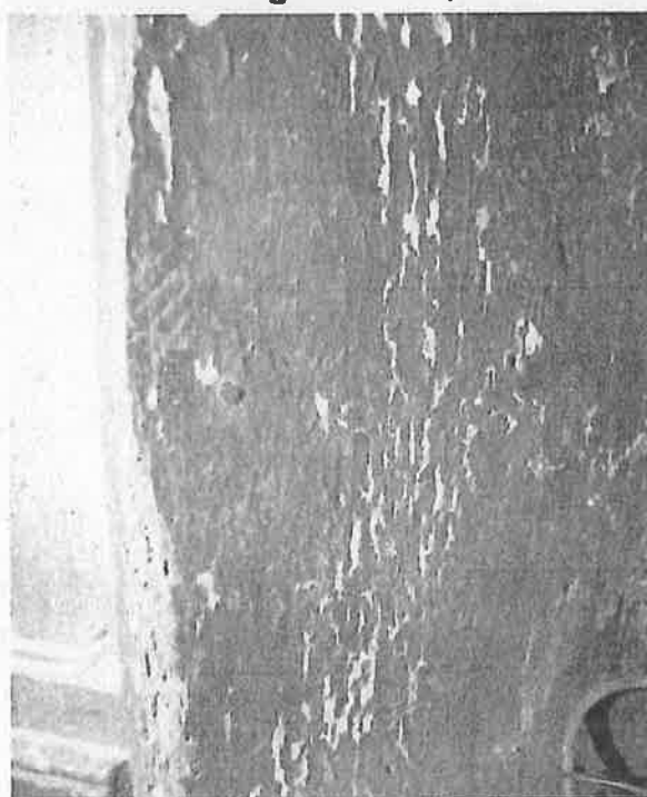
Aspectul versoului (exfolieri ale peliculei cromatice aplicate pe lemn) ↑ / Carbonizare profundă ↓
